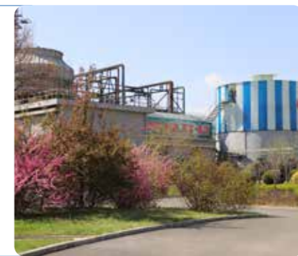
辽宁天利生物氧化项目
