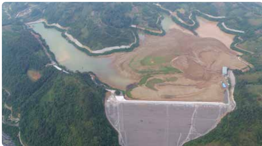
贵州锦丰公司浮选尾矿库
