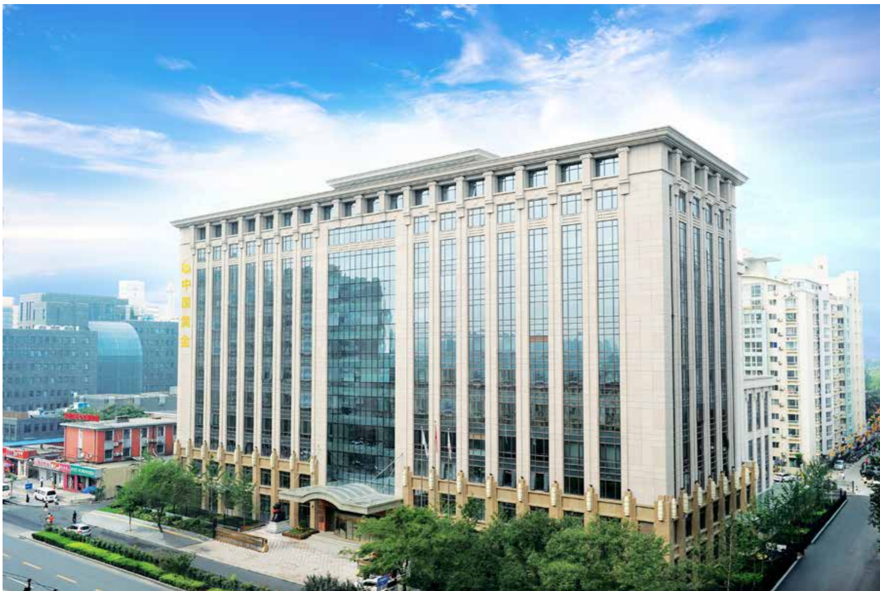
中国黄金总部大楼
