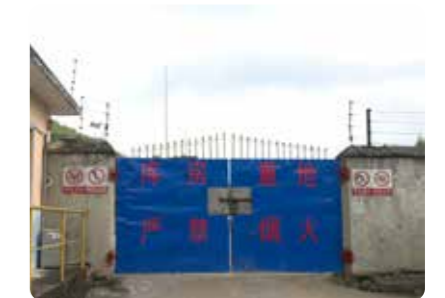
贵州锦丰公司炸药库
